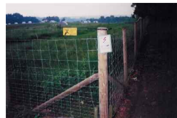
Abb. 5: Außenzaun: unten engmaschig, 1,5 m hoch; Foto: A-Hyppen
